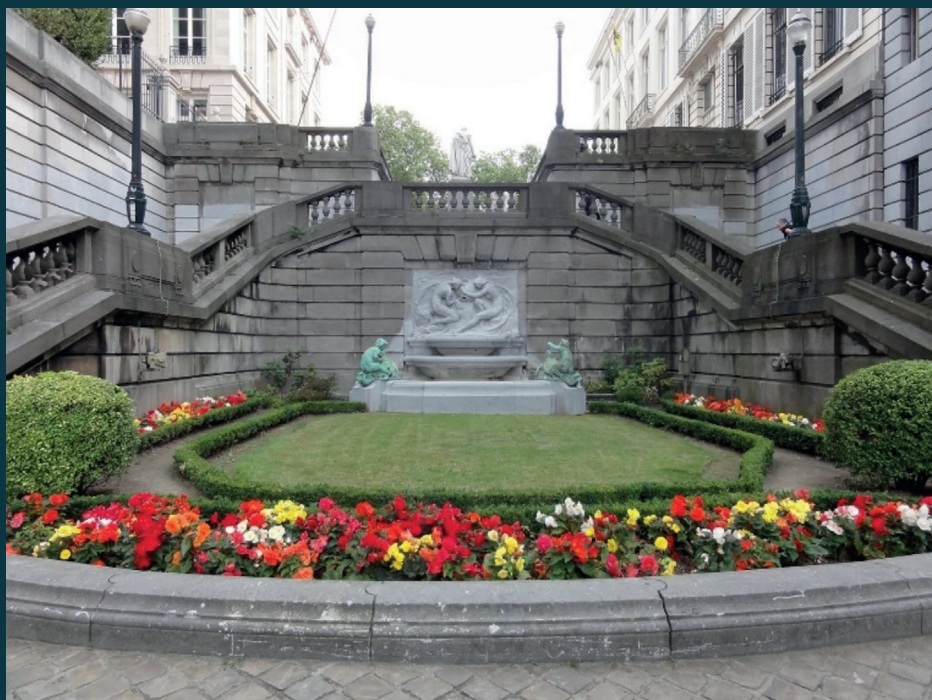
Escalier de la rue Baron Horta exécuté par l'architecte François Malfait entre 1921 et 1923 © wikipedia (état 2012).
