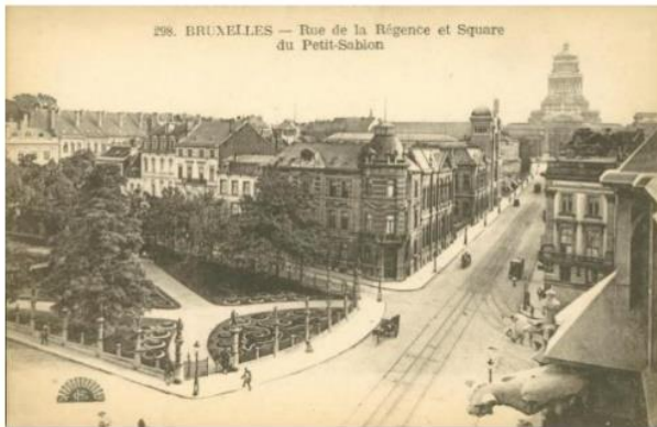
Vue d'époque de la rue de la Régence : trottoirs et rails de tramway s'inscrivent en cohérence avec les formes urbaines. Carte postale issue de la Coll. Belfius © ARB/urban.brussels
