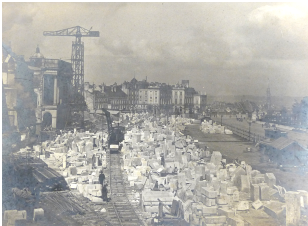
La place des Palais pendant les travaux de la façade. Photographie ancienne, 1904. Archives du Palais royal, Photos, Topographie, B, Bruxelles, Palais royal, n° 663.
