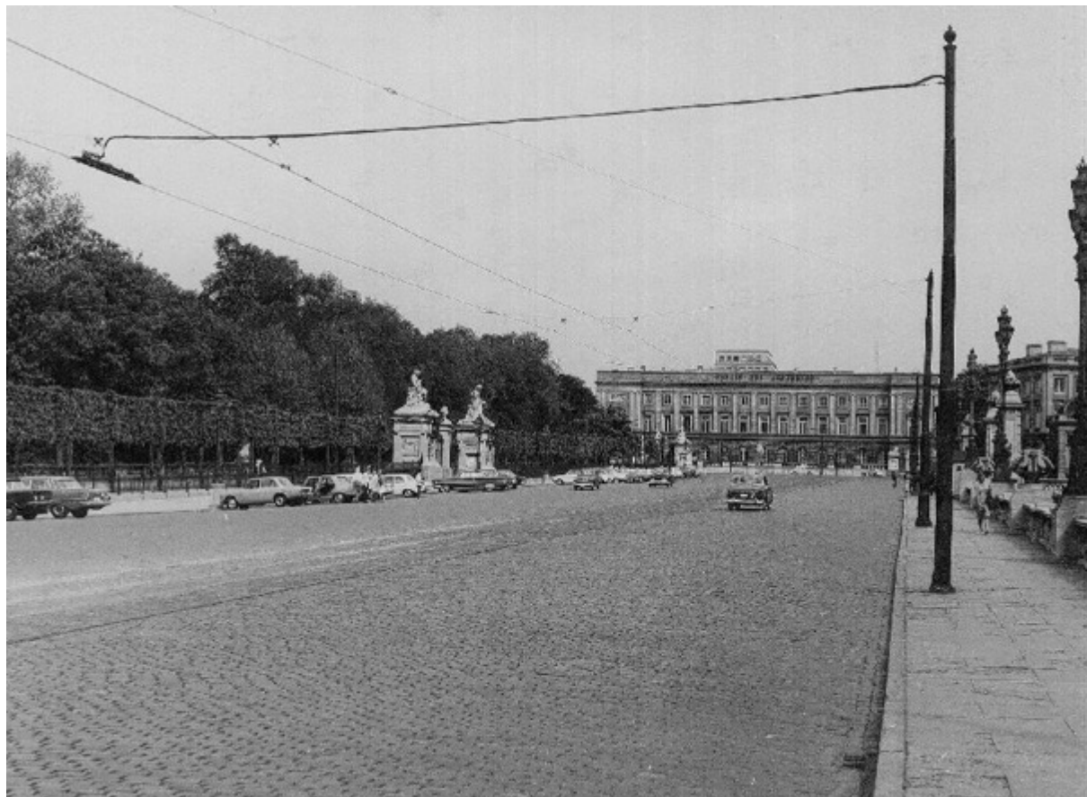
La place des Palais. Photographie IRPA, 1967. © IRPA, cliché M004856. Les nouveaux réverbères sont installés, de même que les vases sur la balustrade.
